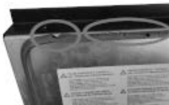
Fig. 27 - joint détérioré
