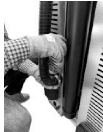
Fig. 60 - Raccorder le tuyau de l'air comburant
