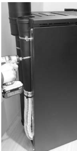
Fig. 38 - Retirer les vis postérieures
