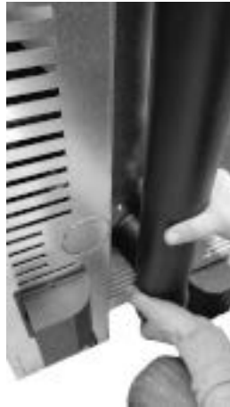
Fig. 59 - Raccorder le tuyau d.80 mm
