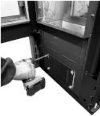
Fig. 92 - Retirer le bouchon
