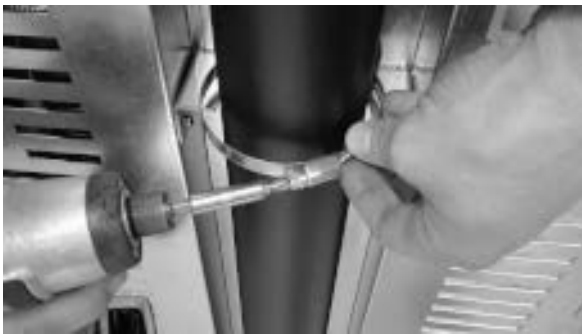
Fig. 61 - Bloquer avec un collier de serrage
