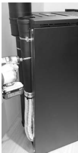
Fig. 28 - Retirer les vis.
