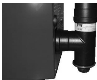
Fig. 72 - Nettoyage du conduit de fumée
