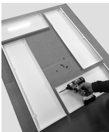
Fig. 30 - Fixation des panneaux 1
