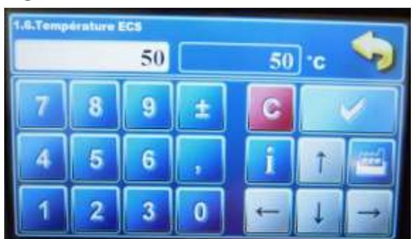
9- Le menu « 1.6.Température ECS » est la température du préparateur ECS à laquelle la pompe d'alimentation du préparateur ECS s'arrête. Sur l'illustration, elle est réglée à 50°C de consigne. Fig. i
