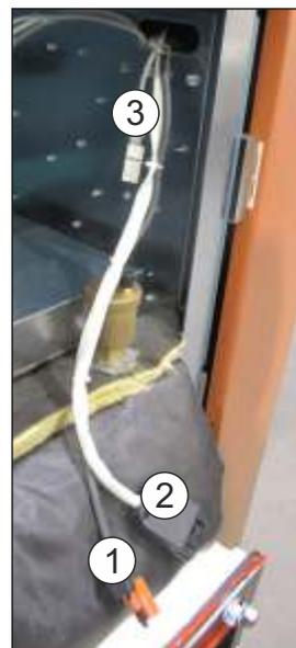
Le côté gauche de la chaudière (bûches) est équipé d'embases préparées, le côté droit de la chaudière (granulés) est équipé de fiches préparées. Les câbles doivent être raccordés dans l'ordre suivant : 1-1 ; 2-2 ; 3-3 ;
