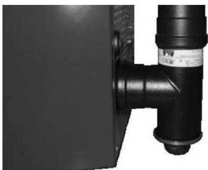
Fig. 72 - Nettoyage du conduit de fumée
