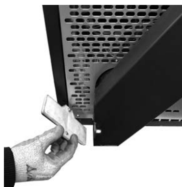
Fig. 73 - Nettoyage du conduit de fumée
