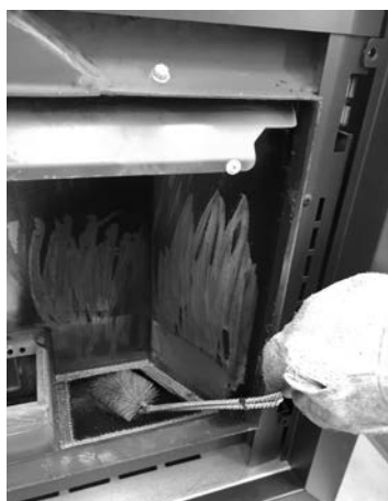
Fig. 76 - Nettoyer avec un goupillon.
