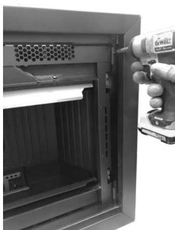
Fig. 30 - Retirer les vis
