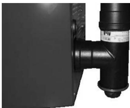
**Fig. 125 - Nettoyage du conduit de fumée**
