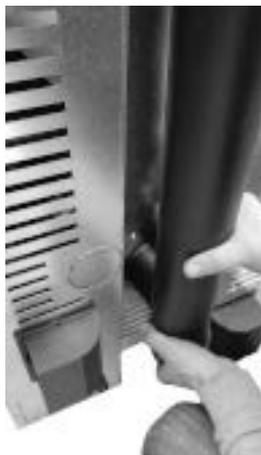
*Fig. 84 - Raccorder le tuyau d.80 mm*
