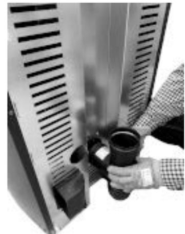
Fig. 79 - Raccorder le raccord en T
