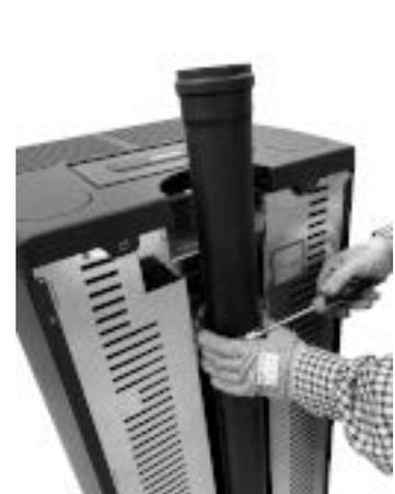
Fig. 82 - Conduit arrière d'évacuation des fumées monté
