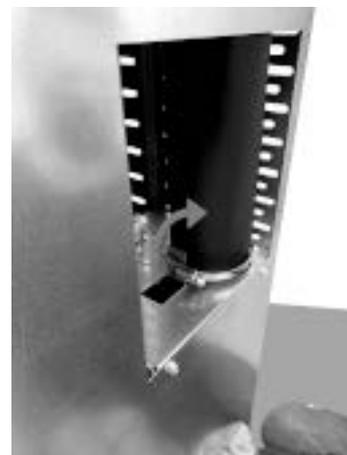
*Fig. 111 - Bloquer le tuyau de canalisation*
