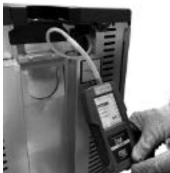
**Fig. 117 - Connexion du pressostat numérique (Atena³ Plus12/14 - Duke 12/14 At - Saba 12/14)**
