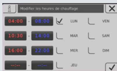
Fig. 2 Vue de la fonction Périodes de chauffage (réglables individuellement)
